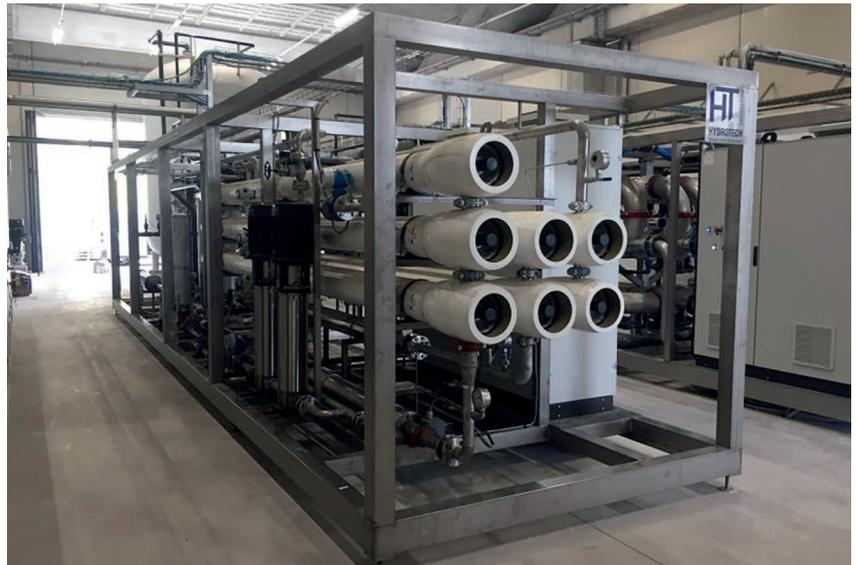
MEMBRANE DI OSMOSI INVERSA (RO) PRE-ASSEMBLATE SU SKID IN UN IMPIANTO PER IL TRATTAMENTO DEL DIGESTATO
